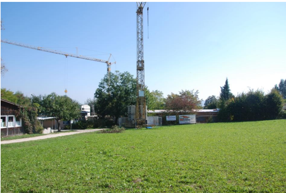
Blick auf die Baustelle
