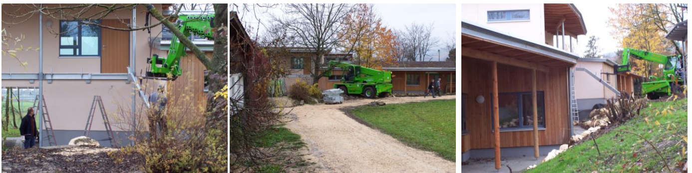
Montage der Außentreppe
